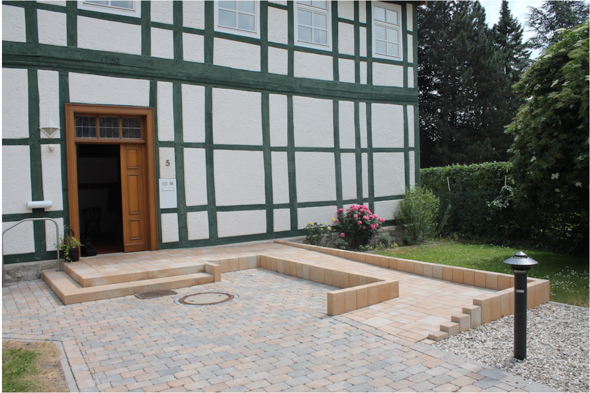
Barrierefreies Gemeindehaus – selbstverständlich mit entsprechenden Sanitäreanlagen
